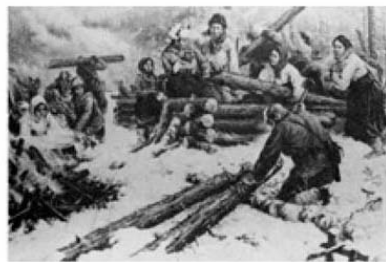
Einwohner der Partisanengebiete bauen nach einer feindlichen „Strafexpedition“ neue Wohnhäuser.
